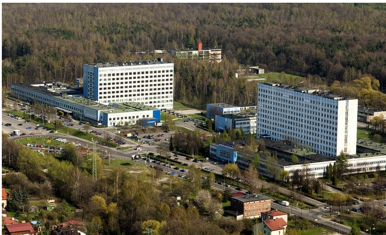
Górnśląskie Centrum Medyczne przed pracami termomodernizacyjnymi i zmianą elewacji budynków.
